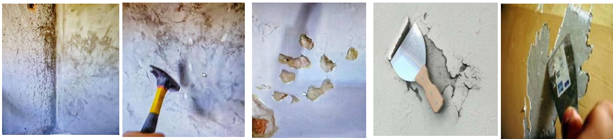
Рис. 3. Способи оцінки старого штукатурного покриття
