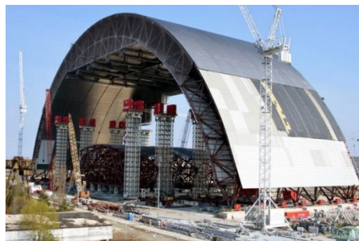
Рис. 16. Арка саркофагу-2, який встановлено над зруйнованим енергоблоком
