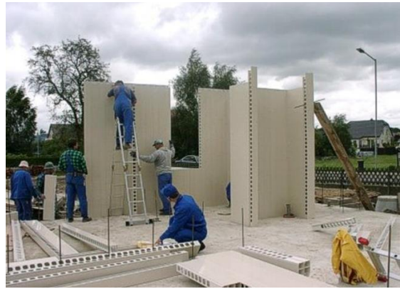
Рис. 9. Будівництво за технологією RBS
