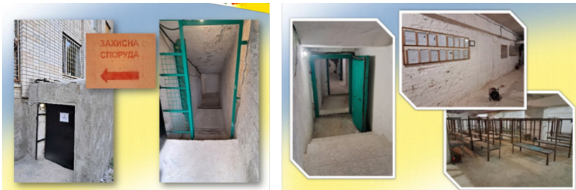
Рис. 6. Захисна споруда цивільного захисту у ДНЗ «Слобожанський регіональний центр професійної освіти»
