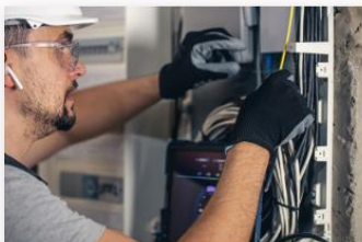
МОНТАЖ ПРИСТРОЇВ ЗАЗЕМЛЕННЯ ТА ЗАНУЛЕННЯ
